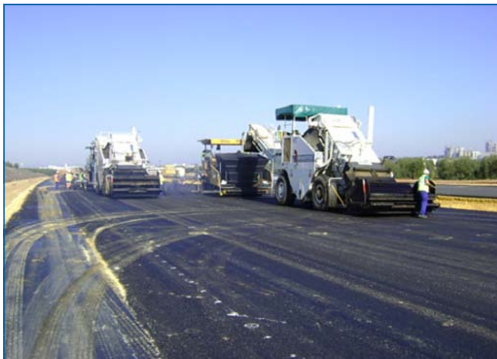
Obras de Carreteras y Hormigones
