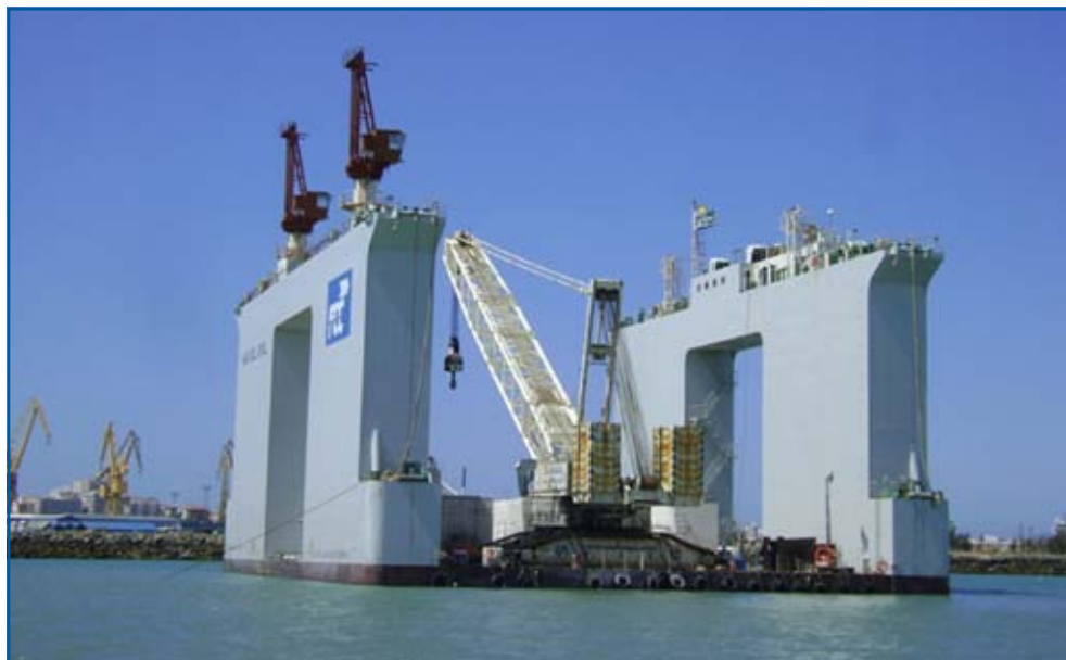
Dique flotante Mar del Enol con grúa. Nueva Terminal de Contenedores de Cádiz.
