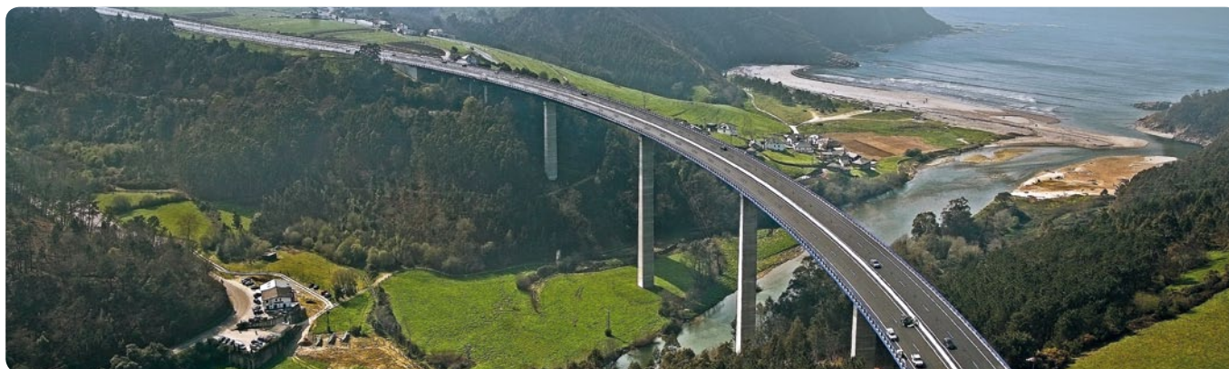
CANERO BRIDGE, ASTURIAS.
