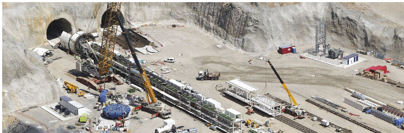
Túnel de Pajares (España)
