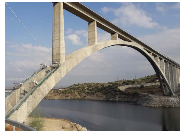
Viaducto de Almonte, Cáceres (España).
