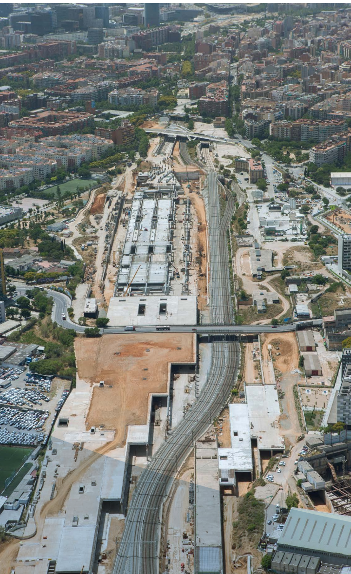
Accesos a la Estación de Alta Velocidad de La Sagrera, Barcelona (España).
