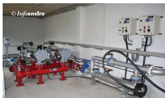
Filtros de malla Hidroglobal a 50 micras para uso industrial
