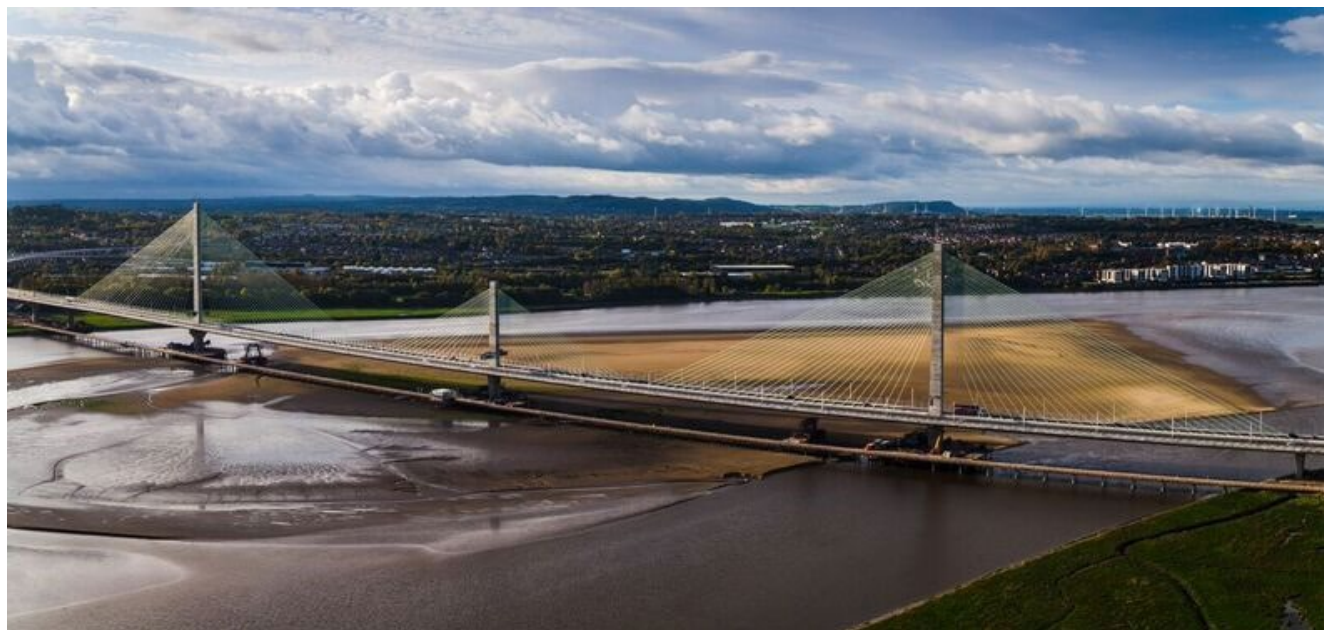
Mersey Gateway Project (Reino Unido).
