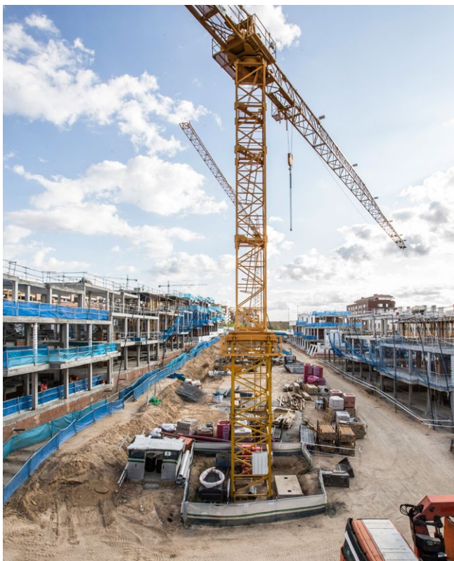
33 Viviendas unifamiliares Nuevo Tres Cantos (España).
