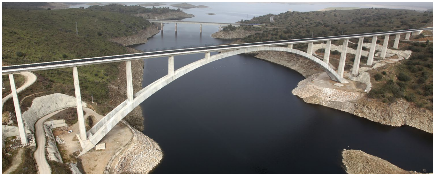
AVE Madrid-Extremadura. Tramo embalse de Alcántara-Garrovillas (España).
