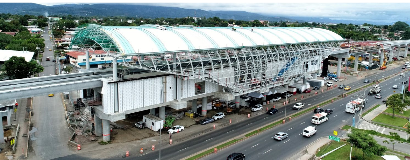
Estación Pedregal. Línea 2 Metro Panamá.
