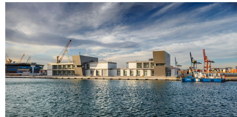
Edificios Servicios Náuticos Puerto Valencia (España).
